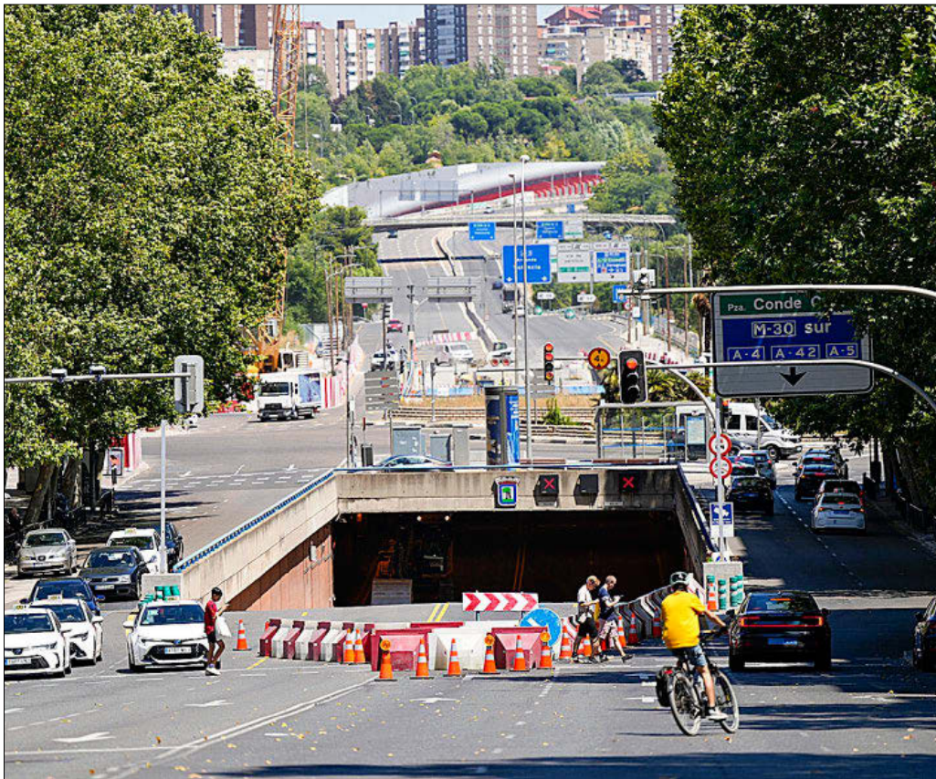
Obras en el túnel de Conde de Casal, ya reabierto, por la línea 11 del Metro. ÁNGEL NAVARRETE
